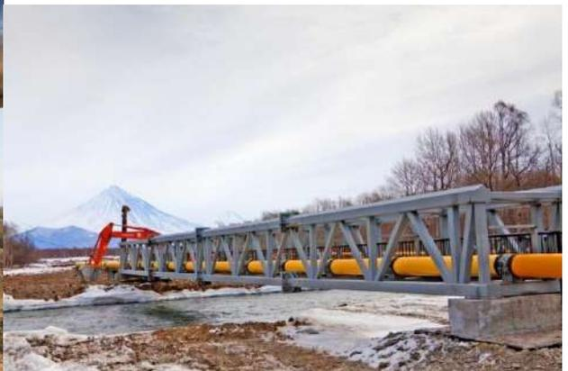
*Рис.35. Трубопровод на эстакаде*
