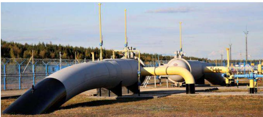
*Рис.36. Узел пуска и приема станции очистки (диагностики) (УППСОД)*
