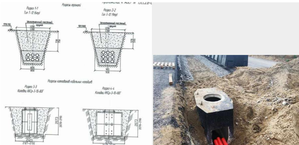
**Рис.50. Устройство кабельной канализации**
