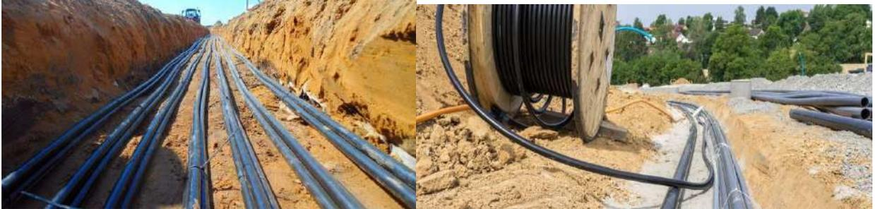
*Рис.47. Траншейный способ укладки кабеля*
