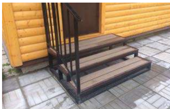
Рис. 16б. Крыльцо, не включаемое в контур здания
