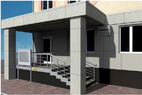
Рис. 17а. Крыльцо, включаемое в контур здания
