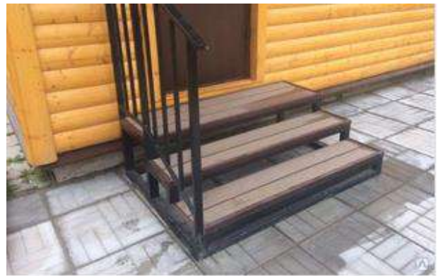
Рис. 17б. Крыльцо, не включаемое в контур здания
