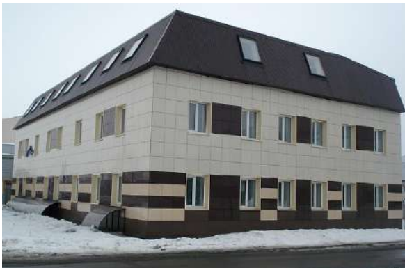
Рис. 18а. Крыша, не включаемая в контур здания
